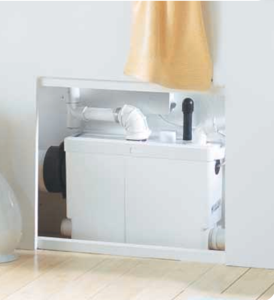
Установленный за стеной, он позволяет совсем незаметно подсоединить подвесной унитаз, раковину, душ.
